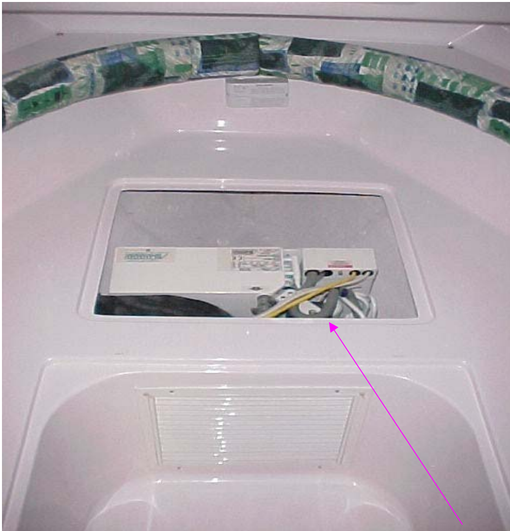
<fig. 10 – Air Conditioner>
